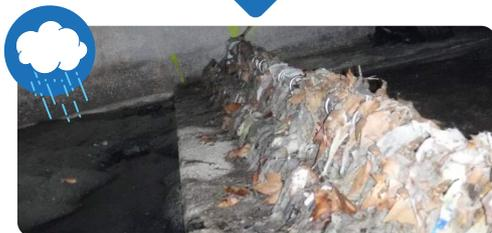
**Abb. 10** - Rückhaltesysteme für Grobstoffe in Mischwasserüberläufen.
